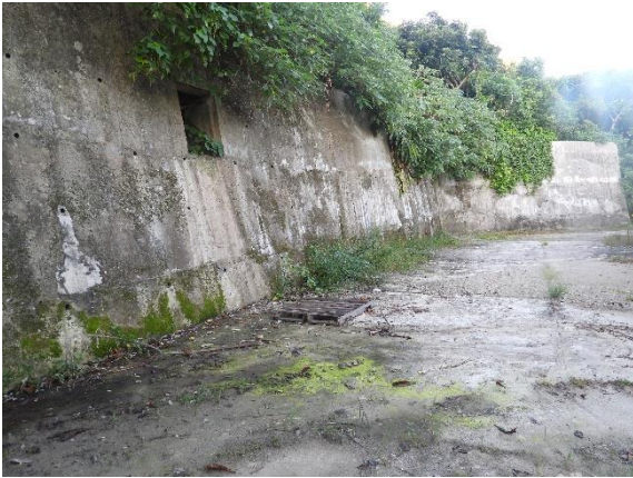
圖 二-86 C 莊敬園區後方擋土牆周遭植被
