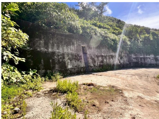
圖 二-54 C 莊敬園區後方擋土牆周遭植被
