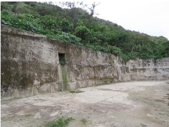
圖 二-15 C 莊敬園區後方擋土牆周遭植被
