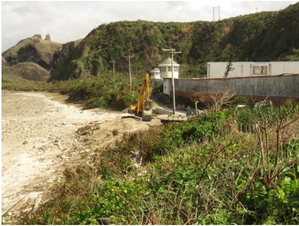
圖 二-130 臨時堆置場施工現況照
