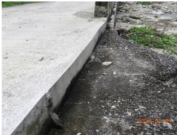
圖 二-77 流麻溝板橋落差現況照
