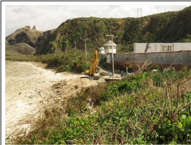
圖 二-39 臨時堆置場施工現況照
