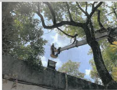
將枯枝進行移除作業
