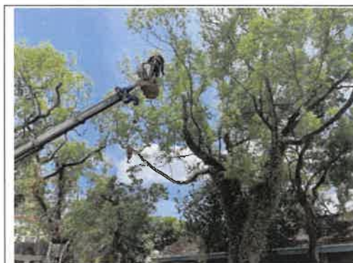
將枯枝進行移除作業
