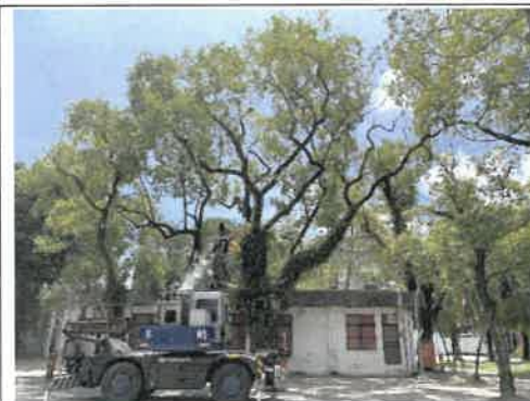
將枯枝進行移除作業
