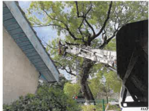
將枯枝進行移除作業
