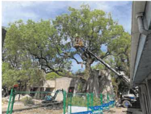
將枯枝進行移除作業
