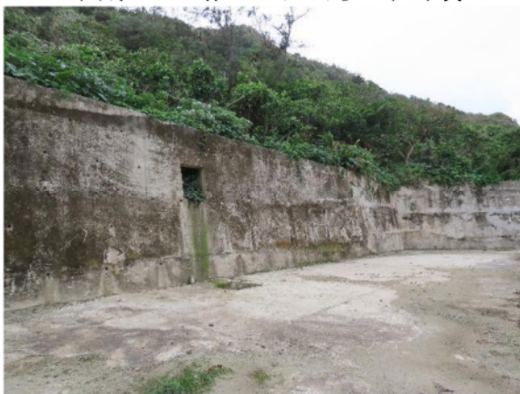
圖 貳-24 C 莊敬園區後方擋土牆周遭植被
