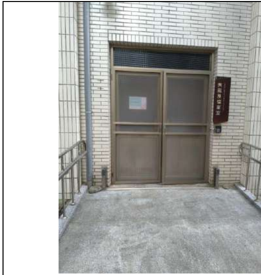
圖 2- 11 一樓入口現況
