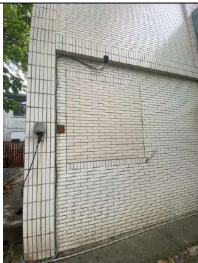
圖 2- 15 外牆表面現況及修補痕跡
