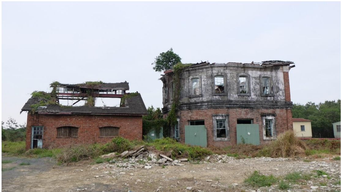
監舍大部分屋頂已經缺損、八角樓之升旗臺及內部樓地板已完全倒塌
