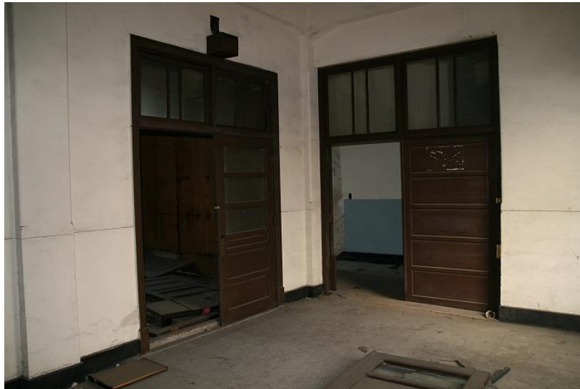
圖十一 華山車站二樓內部（2009） 515
