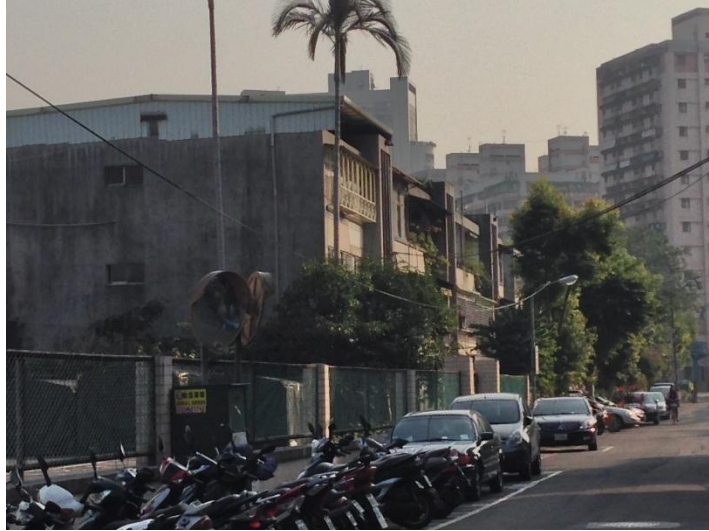
圖八 立清街上停車場旁的民宅 837
