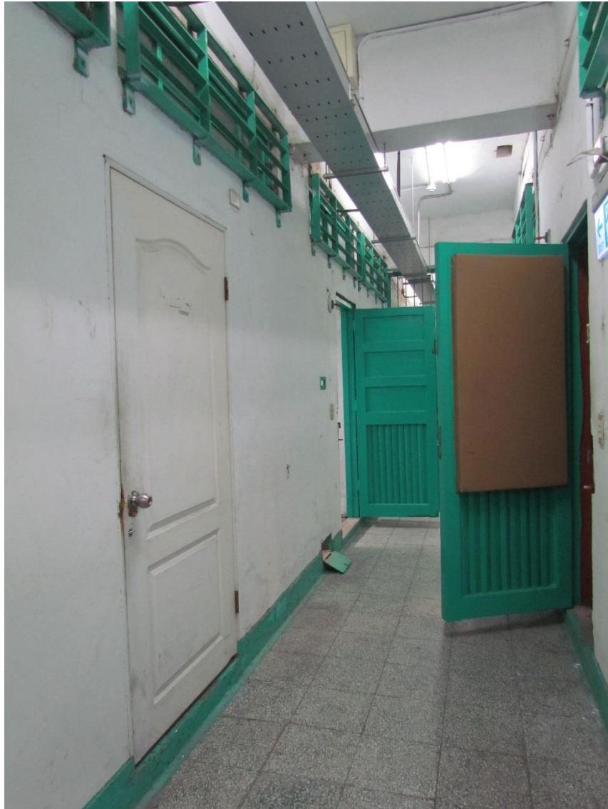
圖十五 仁愛樓內部：雙排密閉式押房 404
