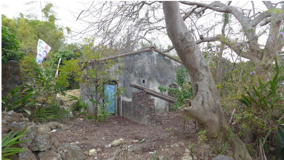
圖六 政治犯關押處之廁所、圍牆殘跡 649
