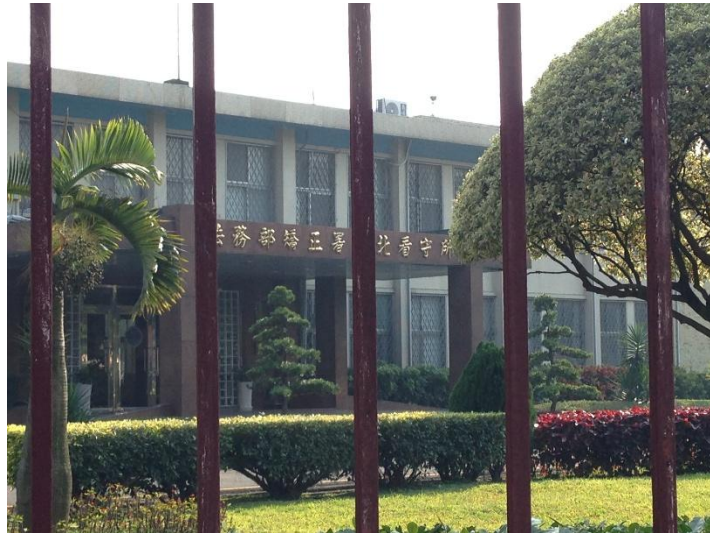
圖三 行政大樓位在立德路一側 832
