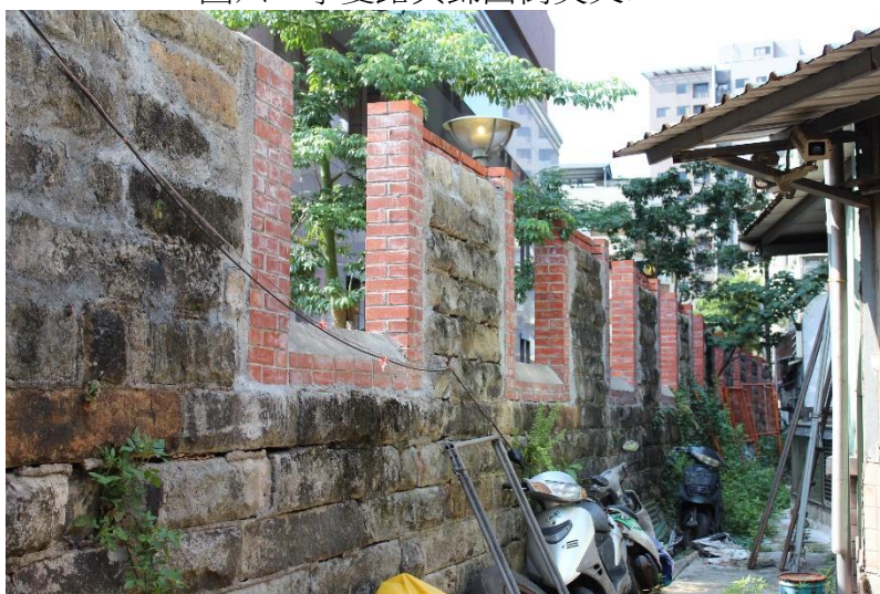
圖七 歸綏街 97 巷 2 弄內，用臺北城牆石所建造之圍牆 278
