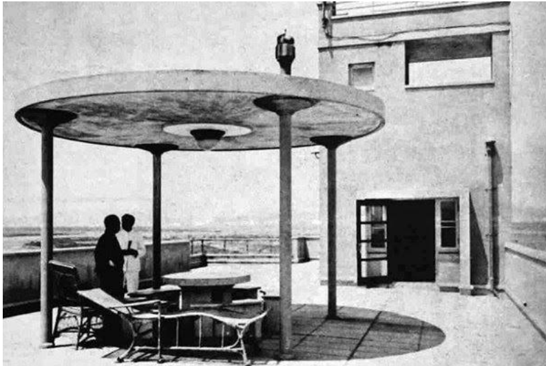
圖五 高橋豬之助的住宅三樓屋頂涼台 192
