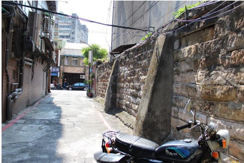
圖八 與新店軍人監獄外牆一樣的城牆結構 279
