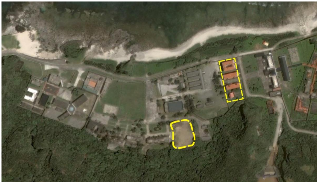
圖 144：莊敬營區「忠貞樓」東側空地綠島監獄宿舍（黃色虛線）
