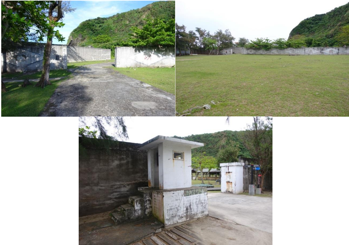
圖 107：莊敬營區圍牆，左上為保養廠大門、右上為保養廠圍牆，下為營區哨站。
