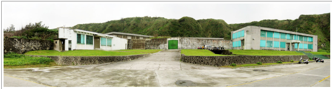
圖 4-17 官兵宿舍立面圍塑綠洲山莊前空間現況照片
