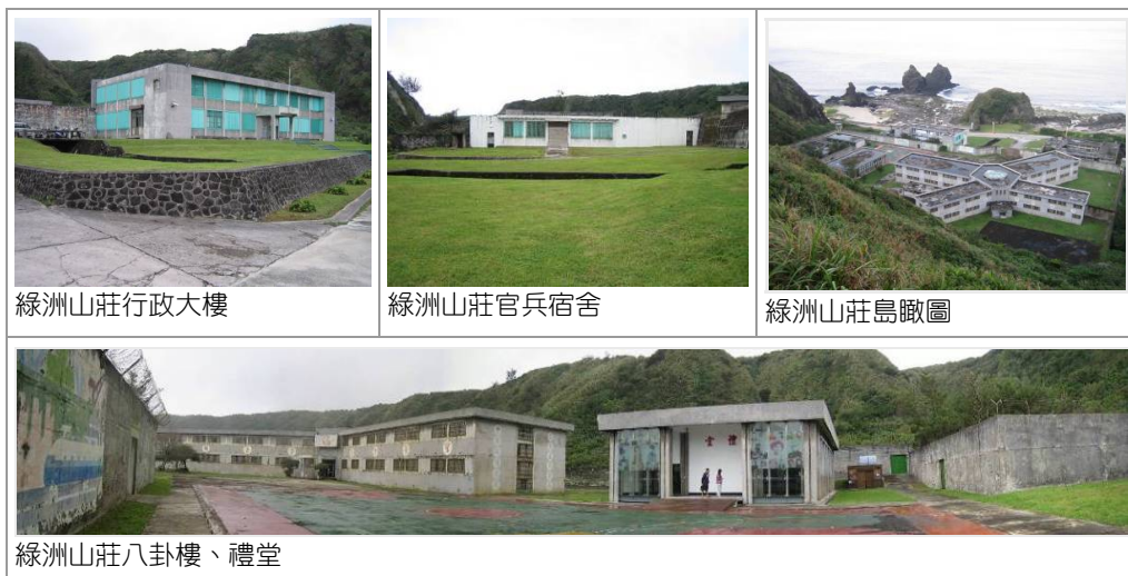
圖 2-9 綠洲山莊現況照片
