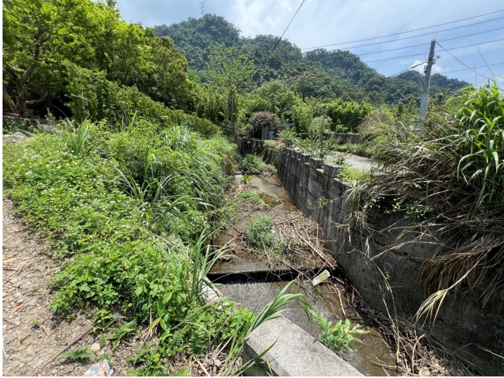
圖 32 教會舊址，建築物已拆除。
