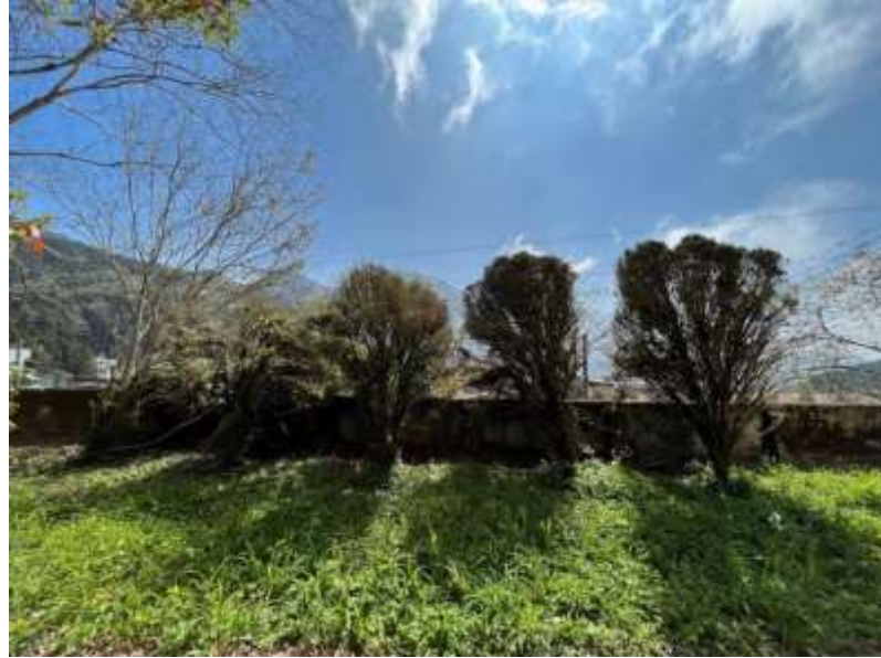
圖九：吳鳳山地治安指揮所外側矮圍牆為遺構，本執行團隊拍攝，拍攝日期：2022 年 2 月 16 日
