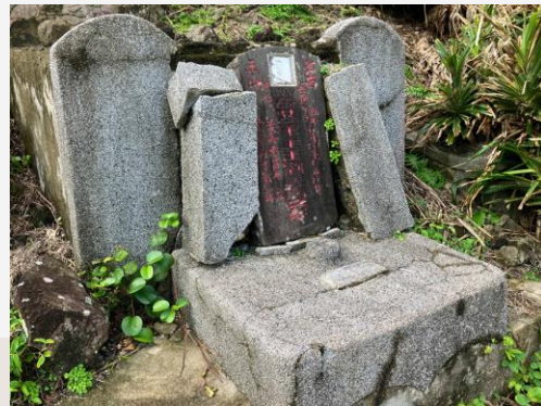
缺乏鋼筋鐵件抵抗拉應力，構造斷裂
