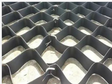
防沈陷格網施工參考示意
