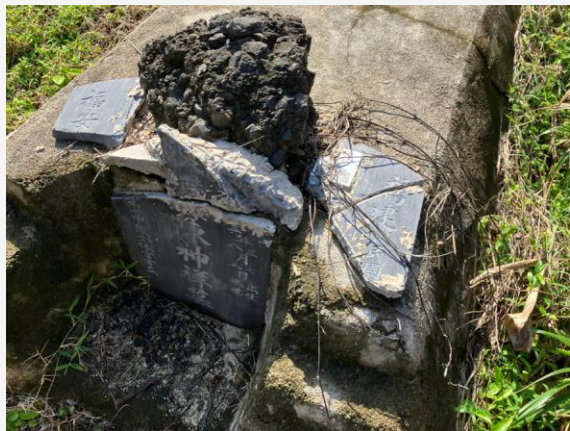
墓碑斷裂現況
