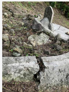
土層滑動構造斷裂
