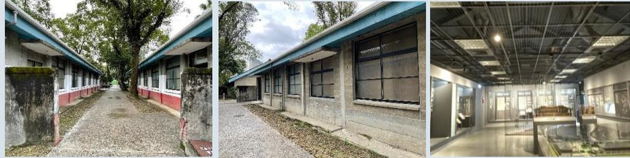
修復後兵舍樣貌，木屋架變更為鋼構、屋瓦更新為水泥瓦並拆除天花
