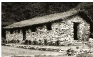
圖中的「克難房」，牆面即是取材自綠島海岸生產的硨磲石，由政治犯自力打石、自力砌牆而成。(陳孟和攝影，唐燕妮提供)
