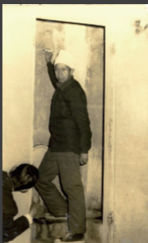
調查局及警局協同現場模擬勘察。(權管局提供)
