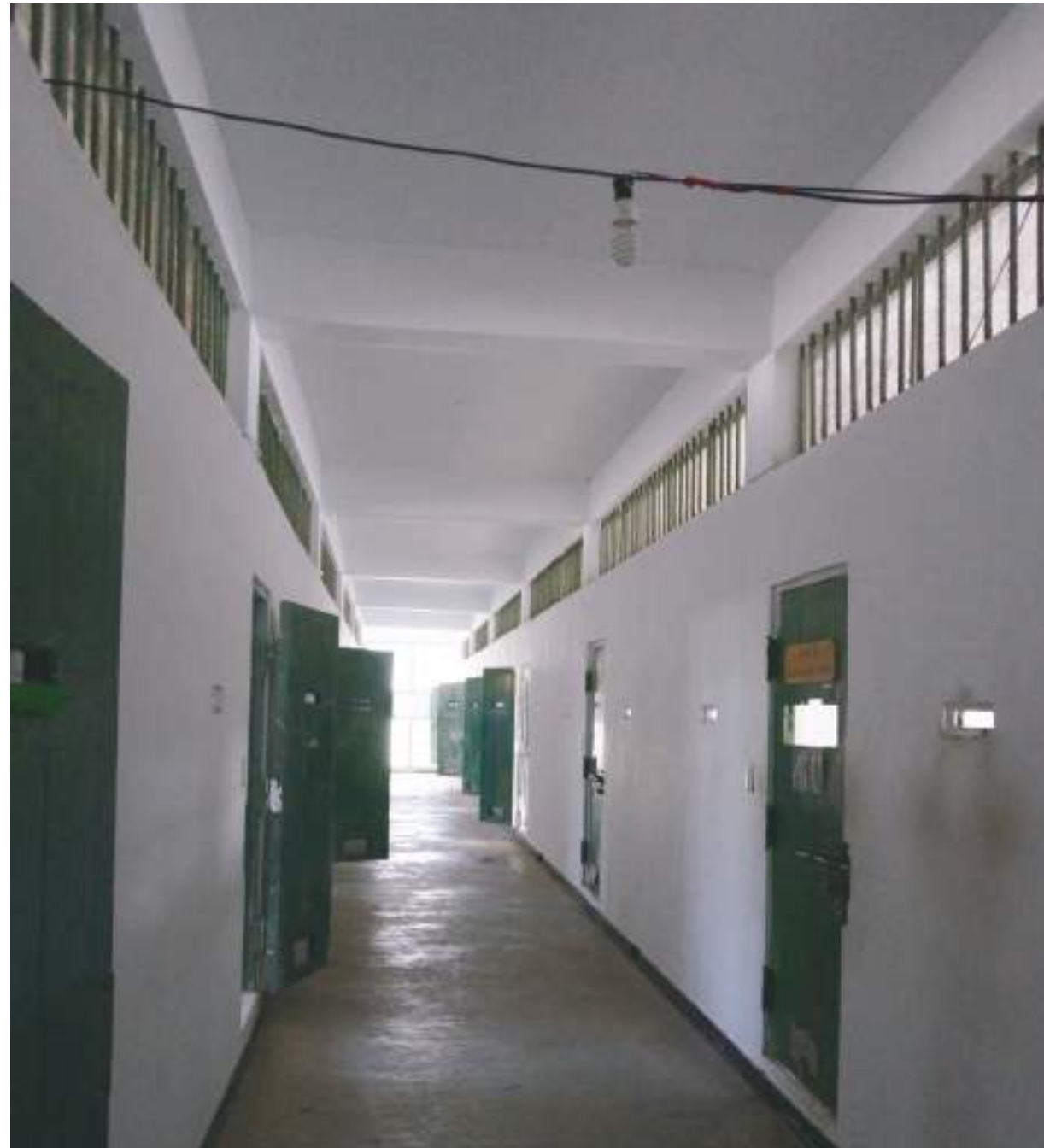
圖為綠洲山莊一翼的長廊。大部分的政治犯關押在一樓，身份特殊或「頑劣份子」則關押在二樓。有別於泰源監獄時期可以到圍牆外服外役，綠洲山莊則是運用圍牆內，押房外的空間作為外役區，將人犯的活動完全限制在高牆內。
