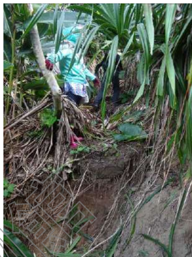
圖 45：部分古道路徑坍塌，行走不易 (本研究拍攝)
