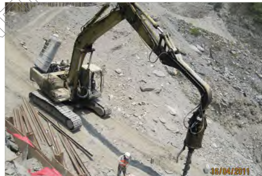
鋼軌樁引孔工法施工照片 (網路照片)
