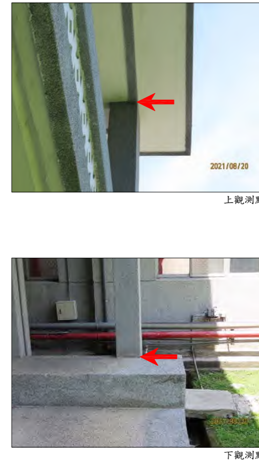
量測標的物牆柱角傾斜觀測位置暨相片編號成果示意圖
