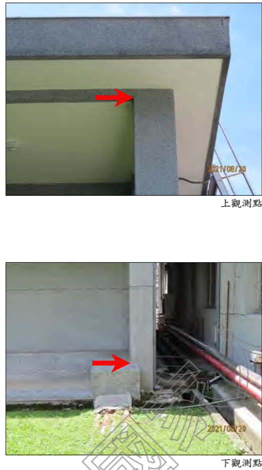
量測標的物牆柱角傾斜觀測位置暨相片編號成果示意圖
