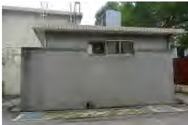
4. 既有圍牆與機房側立面
