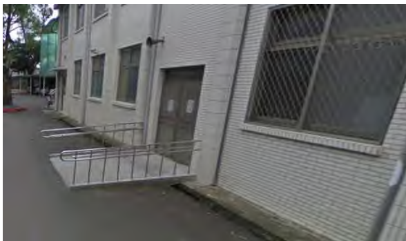
1.正入口設有 2 階踏階，並以無障礙坡道連接門口
