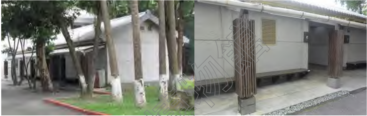
1. 北向立面現況，左圖有喬木樹穴在外；右圖簷廊下設木座椅，步道旁有碎石排水溝
