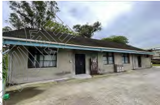
2. 軍法處軍官寢室 2 外壁皆施作水泥砂漿粉光
