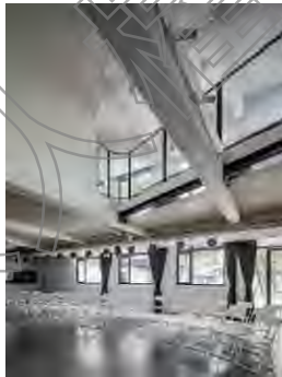
7.二樓樓板局部拆除，保留主樑系統，增設電梯及天井
