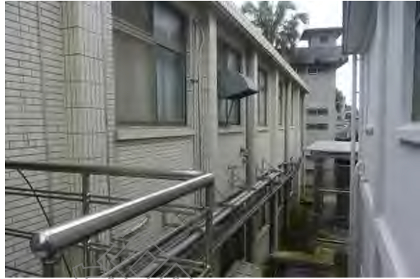
7. 建築東向立面佈滿管線設備
