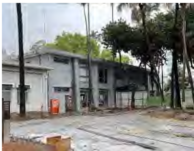
覆判局辦公大樓前方道路整修作業
