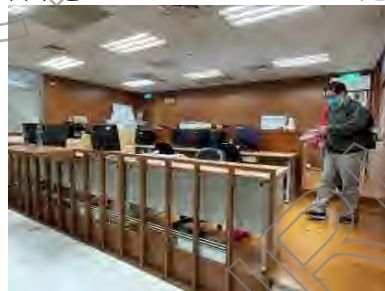
8.一層地坪另一間空間鋪有地磚及木作地坪
