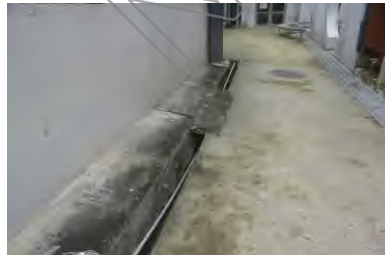
5. 機房周邊犬走及排水溝
