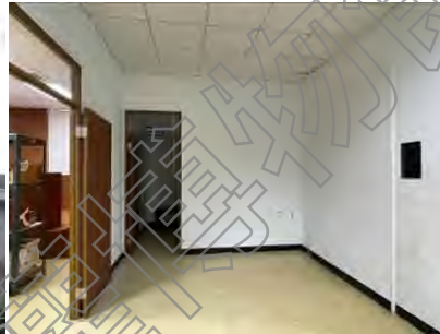
9. 室內多為輕隔間
