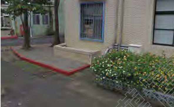
3.建築角隅設置兩種不同形式的花台。左圖為 2012 年街景圖，角落花台鋪貼了與外牆一樣的壁磚 右圖為 2022 年建築修復後，角落花台已混凝土澆置填滿，而綠地空間緣石保留。
