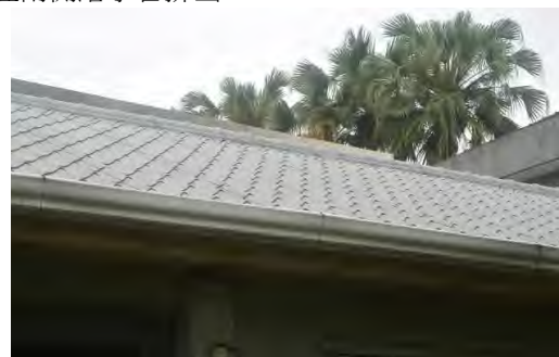
3.屋頂之琉璃鋼瓦
