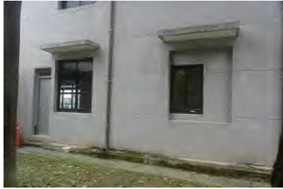
11. 西向立面既有窗戶開口，部分窗戶縮小尺寸，但既有窗框和雨遮均保留
