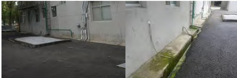
4-1.建築後方重新鋪設柏油
