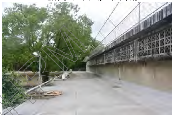
4. 建築東向立面與軍法局看守所共構，二樓立面開窗形式
