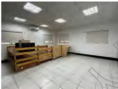
4.室內輕鋼架天花板
