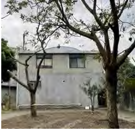
1. 北向立面與圍牆共構
