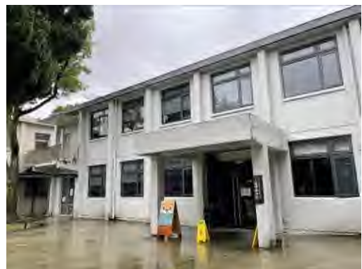
軍法局法院 2 (現人權學習中心) 正面出入口現況
