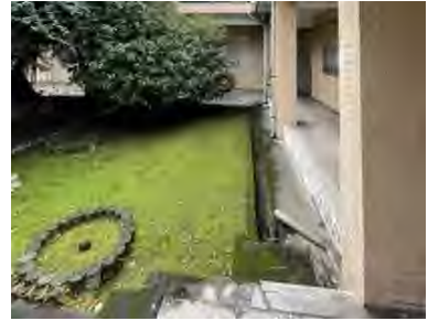
4-3.中庭側犬走及排水溝
