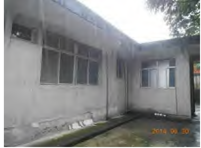
3.建築周邊設有犬走及排水溝
