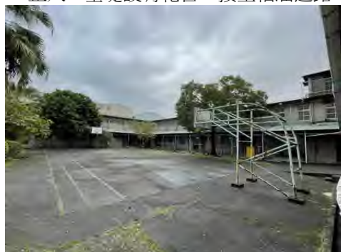
3.中庭籃球場地坪為混泥土坪
