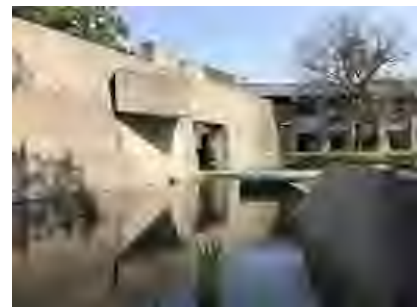
3. 建築外廣場及水池現況
