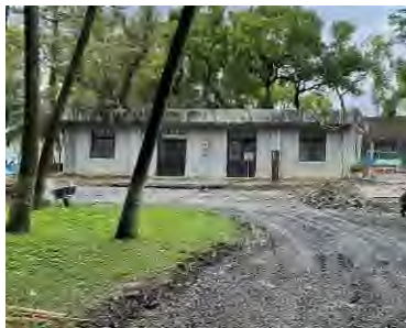
1. 軍事法庭前方道路整修作業
