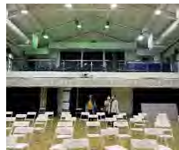
禮堂二樓夾層及天花現況
