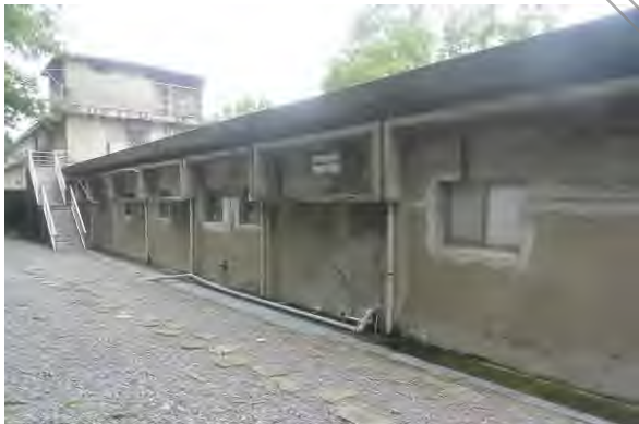
5. 建築南向立面左半邊設有樓梯且開口多更改痕跡
