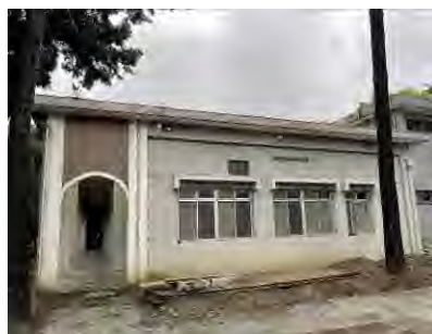
第一法庭側邊外觀現況
