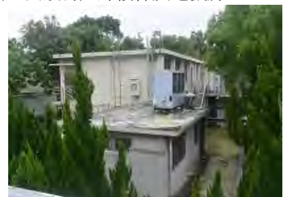
5. 建築東南處設有一間電機房
