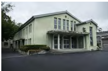
結構補強後的禮堂外觀
