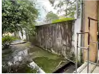
4-2.中庭圍牆與簷廊銜接一角
