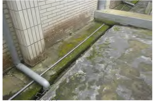
4.建築後方犬走及排水淺溝，多已長苔
