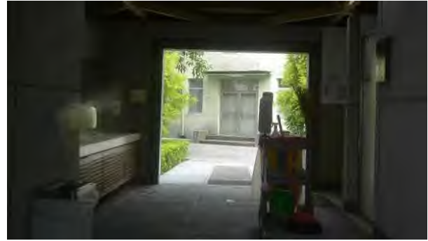
3.左圖為川廊與戶外地坪，兩者皆使用洗石子鋪設。右圖為川廊內部地坪，可看出地坪分割線統一
