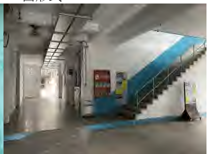
7. 辦公室區域的壁面漆有藍、白色漆料
