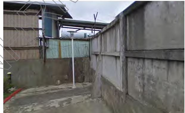
16. 汪希苓特區圍牆與既有圍牆連接處，可見高低差
