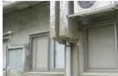
15.水泥框更動、破壞痕跡
