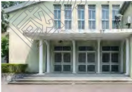
1.正面設 4 階階梯，地坪高度與右側花台齊平
