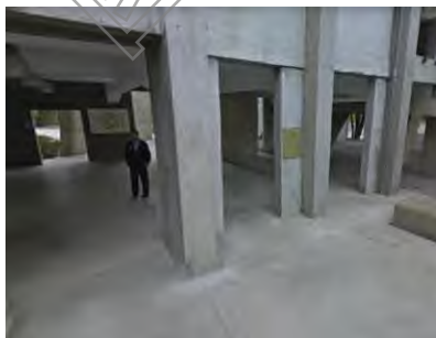
1. 一樓室內外地坪重新施作，統一為水泥砂漿粉光材質
