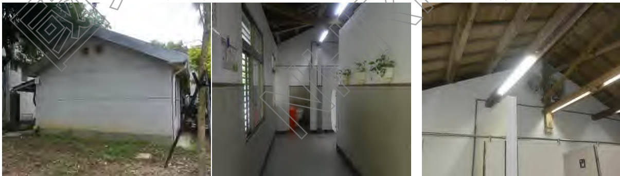
3. 西向立面洗石子外牆設有水平分割線，山牆處設有氣窗
