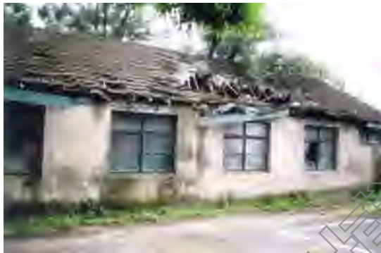
1. 軍法處軍官寢室 2 北側原有牆面及屋頂樣貌
