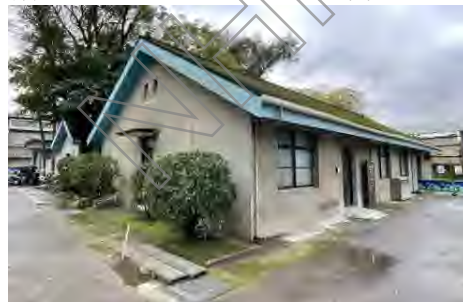
6. 軍法處軍官寢室 2 外牆水泥粉光塗佈
