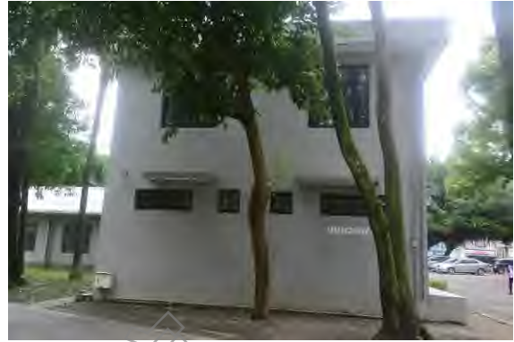
4. 南向立面塗佈水泥漆塗佈，且開口窗檯皆更新。左圖為 2012 年街景，外牆油漆斑駁、褪色；右圖為 2022 年，水泥漆更新。
