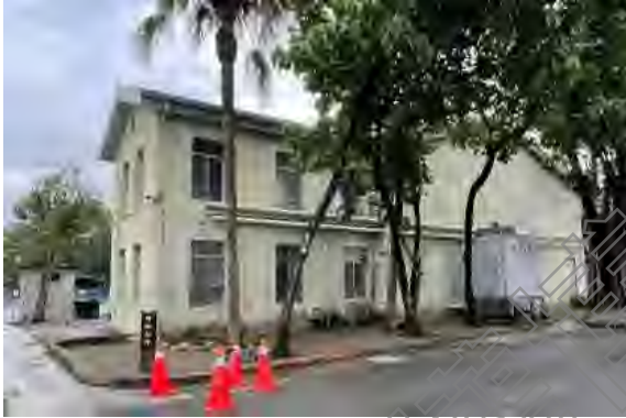
6. 後方留設綠帶，目前種植喬木、設置空調設備
