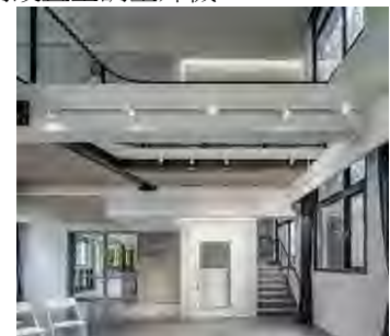
9. 新設鋼樑搭接既有結構
