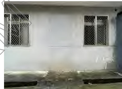
3. 機房後方開口被封閉痕跡
