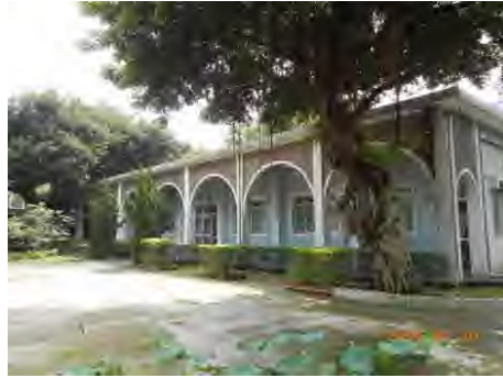
3. 西向簷廊外設有圓拱造型牆及落柱
