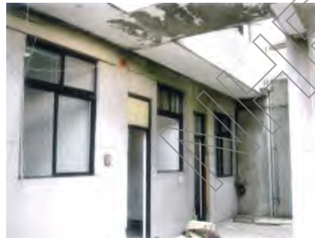
2. 一樓室外出簷天花板
