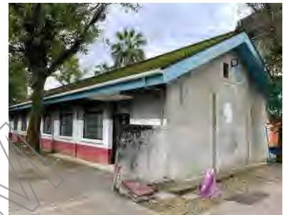
7. 西側短向設有磚牆突出
