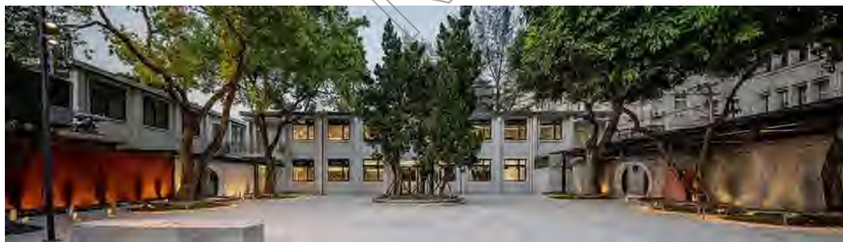
1.南向立面建築外觀，兩側鋼構圍牆皆為 2018 年修復工程時完成
