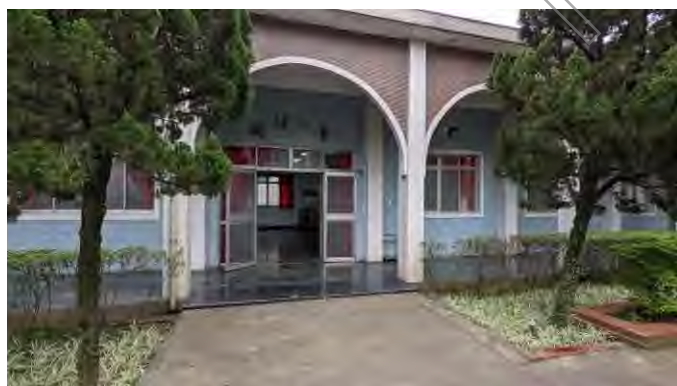
1.外廊地磚及混凝土地坪連接，兩側設有花台、綠地
