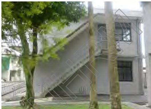
7. 北向立面塗佈水泥漆，扶手欄杆也重新上漆
