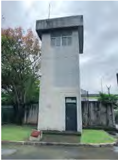
1.東向立面開口
