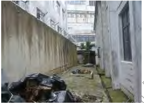
5.建築後方既有犬走及排水淺溝
