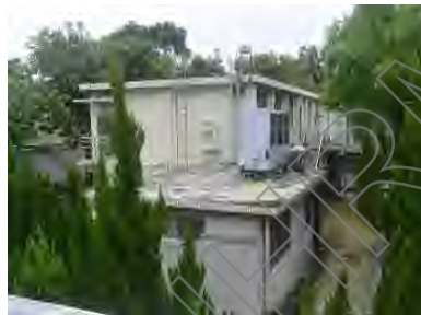
2. 機房設施為平頂建築
