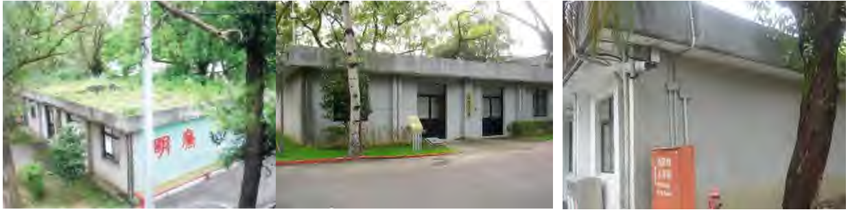
1. 建築修復前屋頂板長滿雜草 2. 建築屋頂修復後現況 3. 室外天花樓板的油漆斑駁脫落
