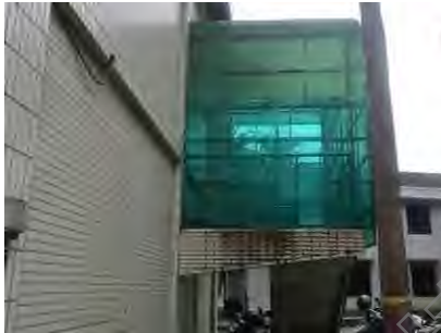
8. 北向立面設有遮光罩樓梯間
