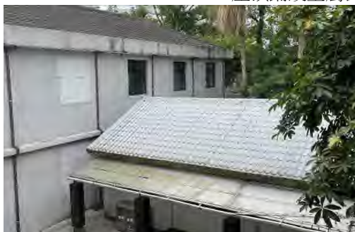
2.琉璃鋼瓦和 PC 中空板俯視照
