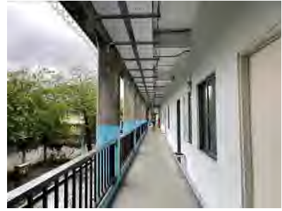
7.二樓走廊地坪
