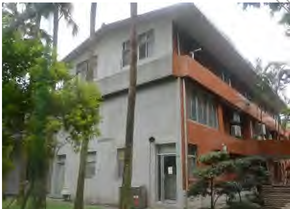
5.東向立面設有兩處側門
