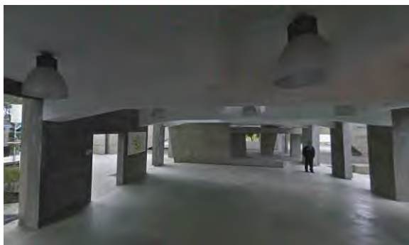
1. 一樓無施作天花板，樓板外露並以油漆塗佈
