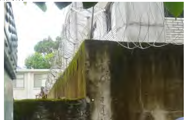
5. 汽修大隊圍牆與既有磚牆的高低差
