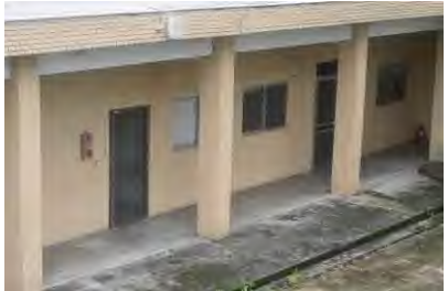
10.中庭側簷廊落柱及牆壁飾材
