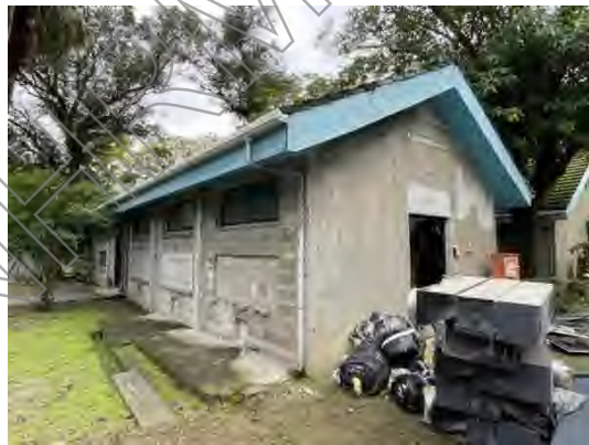
2. 南側立面開口部分被封閉
