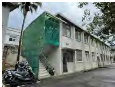
4. 丁掛磚立面及樓梯遮光罩
