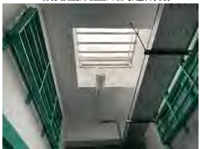
7.二樓押房區走廊設置天井
