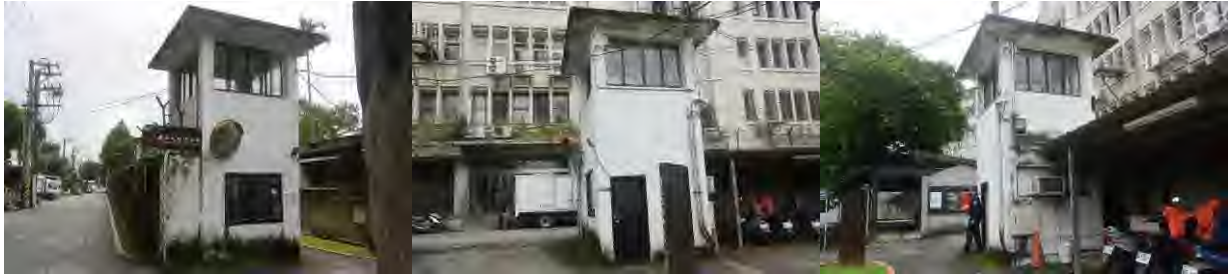
1.北向立面與圍牆連接
