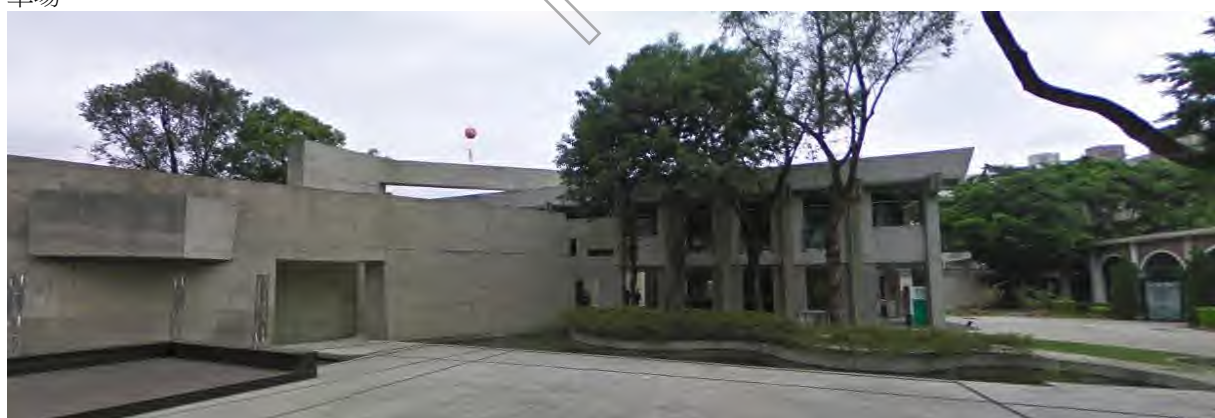
上 3/左 3 視角，軍法處辦公大樓改善後外觀，設有擋土牆及前方廣場，喬木保留原址
