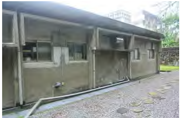
6. 南向立面右半邊可見開口更改痕跡
