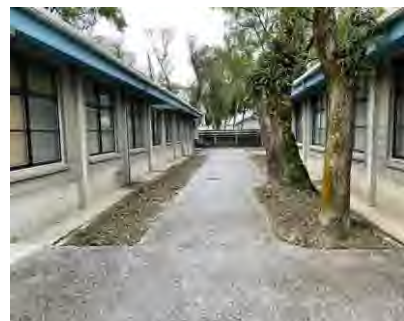
3. 戶外重新鋪設洗露骨材及與綠帶順接的無收邊步道。
