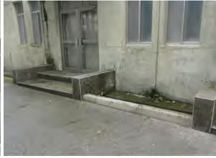
5-2 左側出入口兩側矮墩改善，並重新施作路緣石
