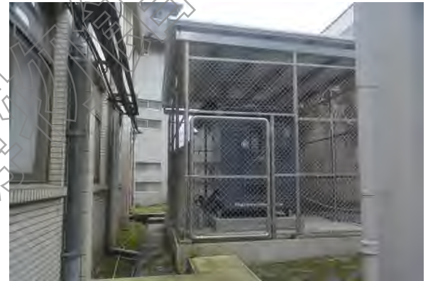
6.建築後方地坪設置機電設備
