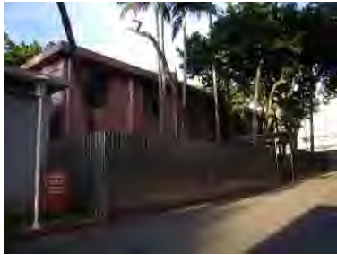
3-1. 北側建築修復前地坪
