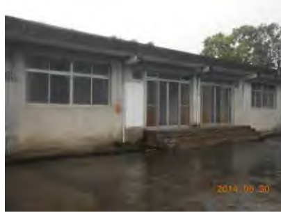
2.主要建築地坪抬高，設有階梯
