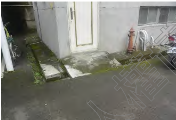
1-2.入口設置斜跨板與道路銜接
