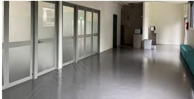
8.二樓室內地坪鋪設亞麻仁油地板
