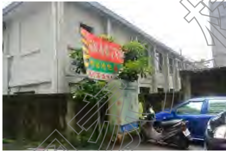
6. 建築北向立面，雖重新以白漆塗裝，但表面髒汙明顯，目前設置空調室外機
