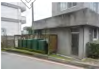
1.東向立面開口被電箱阻擋
