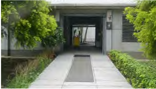
3.左圖為川廊與戶外地坪，兩者皆使用洗石子鋪設。右圖為川廊內部地坪，可看出地坪分割線統一
