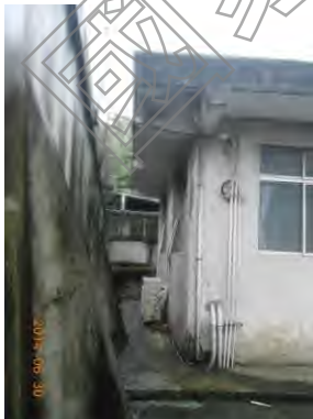
14. 圍牆內側設置斜撐柱
