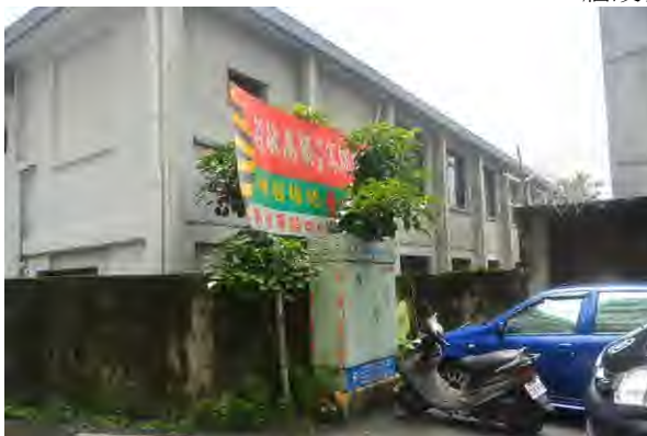
4. 汽修大隊的圍牆與既有磚牆連接處
