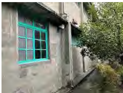
5. 原壁面材料為水泥粉光
