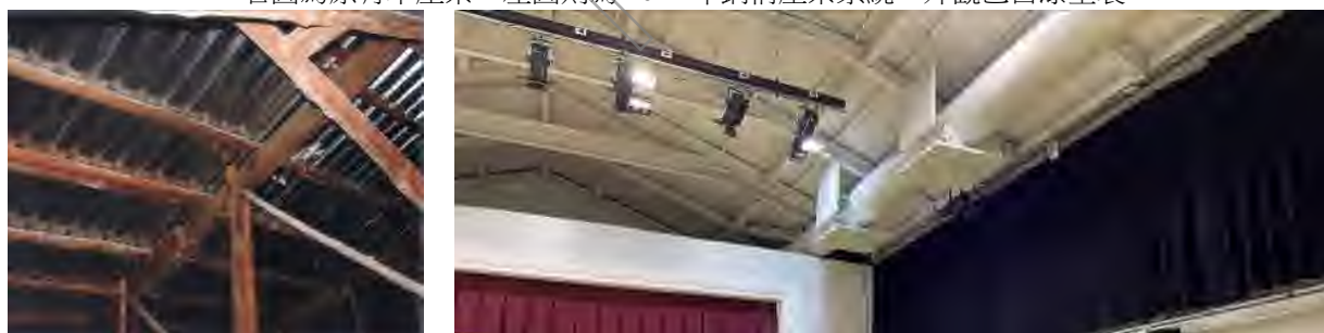
1-2 右圖為原有木屋架；左圖則為 2022 年鋼構屋架系統，外觀為水泥纖維夾板並白漆塗裝
