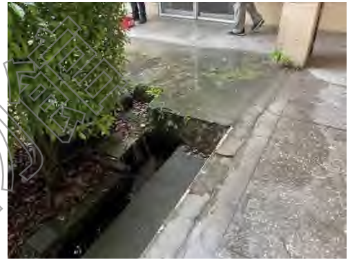
5-2.中庭側犬走及排水溝部分作為暗溝使用
