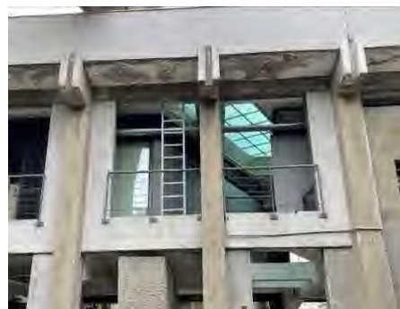
2. 二樓屋頂板部分拆除後設置天井採光
