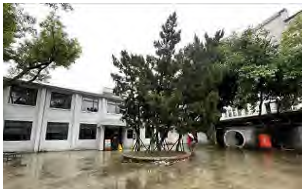
軍法局法院 2 (現人權學習中心) 前方圓形花台及側邊圍牆現況
