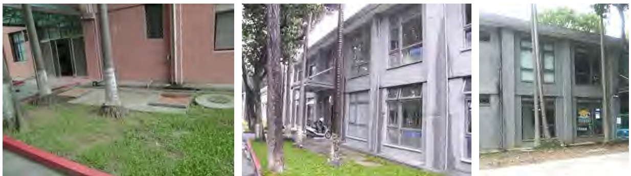
1-1.南側建築基礎設有犬走設施及地下設施物。左圖為修復前犬走外觀；右圖為修復後地坪外觀
