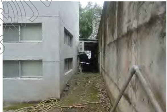
2.後方距圍牆近，且已墊高無法看到犬走和排水溝
