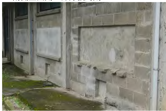
4. 空心磚外牆及封閉開口, 可見不同時期施作痕跡
