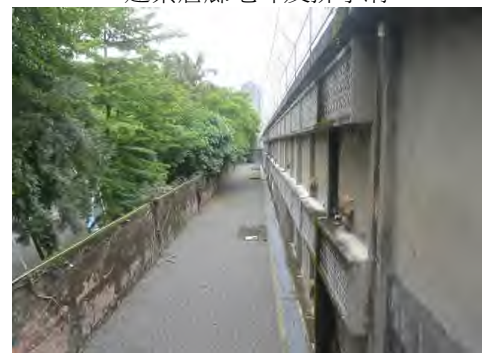
4.建築後方鄰近圍牆且基礎設有排水溝
