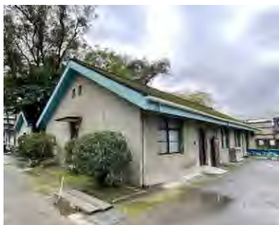
1. 從兵舍出入口可見內部地坪抬高、以斜坡道連接
