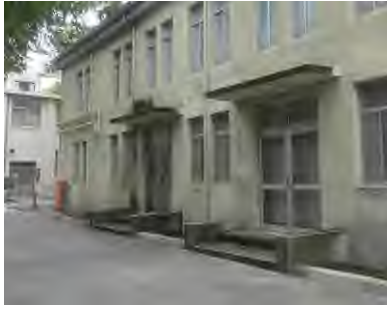
5-1 左側出入口緊鄰道路，開口雨遮及平台橫跨排水溝至道路
