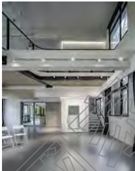
7.二樓樓板局部拆除，保留主樑系統，增設電梯及天井
