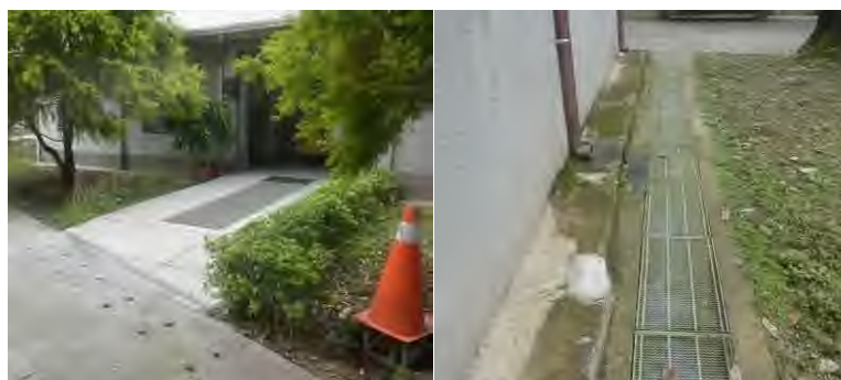
2. 左圖為出入口銜接至道路，道路邊設置暗溝。右圖為建築後方留有犬走及排水溝，落水管接至犬走
