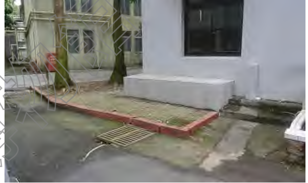
3.建築角隅設置兩種不同形式的花台。左圖為 2012 年街景圖，角落花台鋪貼了與外牆一樣的壁磚 右圖為 2022 年建築修復後，角落花台已混凝土澆置填滿，而綠地空間緣石保留。
