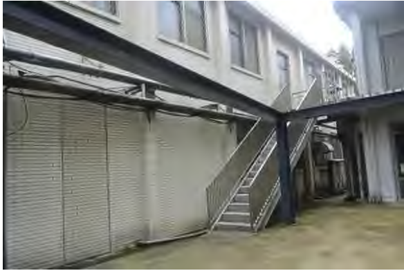
6. 建築東向側設有一座戶外樓梯
