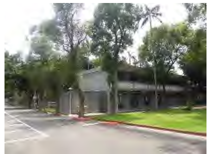
覆判局辦公大樓面向秀朗橋側建築立面及外加設備格柵外觀
