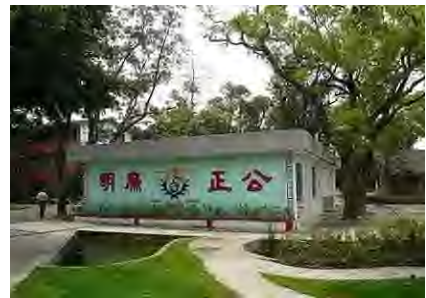
3. 北側外牆標註「公正廉明」字樣
