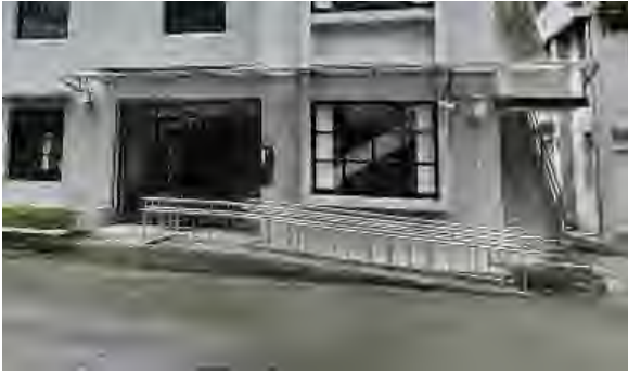
1.入口設有 2 階階及無障礙坡道
