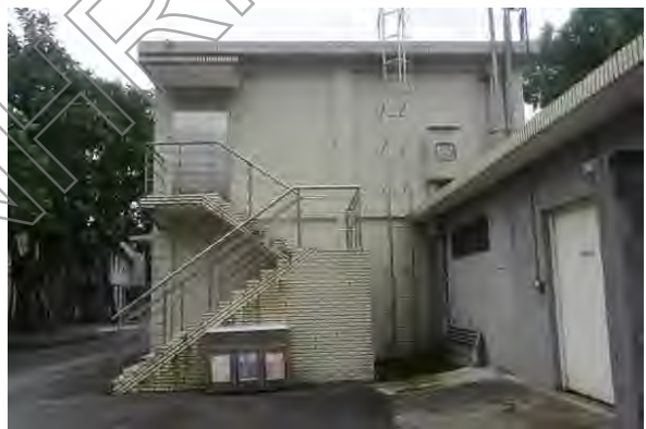
2. 建築南向立面設有戶外樓梯及電機房
