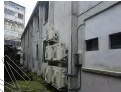
6. 建築北向立面，雖重新以白漆塗裝，但表面髒汙明顯，目前設置空調室外機
