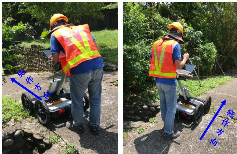
圖5-1 現地透地雷達檢測施作照片(掃描方向如箭頭所示)
