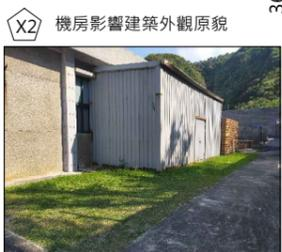
空調拆除內容：空調鍍鋅鋼板機房(含門)、冷卻水塔木格柵、空調主機(含管線)、冷卻水塔(含管線)、15公分PC地評
