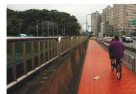
5. 自行車道(橋上)
