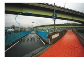
8. 新店側自行車牽引道
