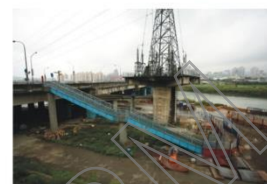
3. 中和側自行車牽引道
