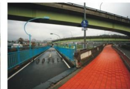
8. 新店側自行車牽引道
