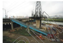
3. 中和側自行車牽引道
