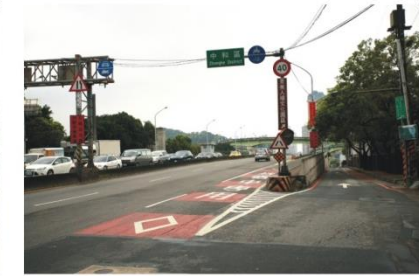
6. 新店側車行路線(橋下引道)
