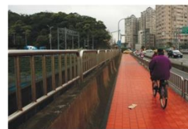
5. 自行車道(橋上)
