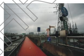
4. 自行車牽引道入口
