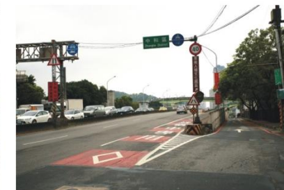
6. 新店側車行路線(橋下引道)
