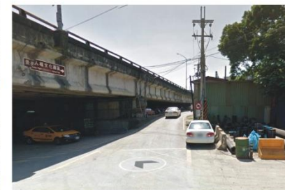
6. 環河路車行路線(橋下引道)
