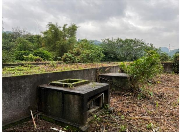
圖 2-9 修養區關押房頂部通氣窗，現況頂部蓋板佚失、雨水直落、植被竄生
