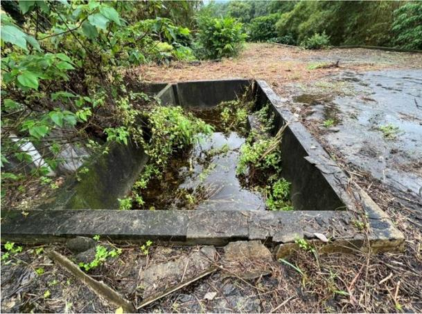
圖 2-8 修養區警衛室後方儲藏室(R13)屋頂版降低下凹，現況排水孔堵塞形成水池
