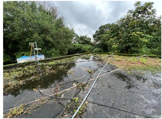
**圖 2-5 工作區屋頂原洩水方向之排水孔堵塞雨水淤積於屋頂四周邊緣**
