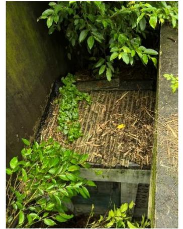
**圖 2-7 地下連通廊道接休養區屋頂-石棉瓦浪板現況附生植栽及落葉**
