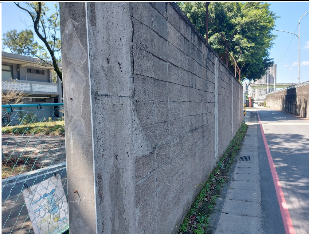
照片 1：圍牆位置，復興路側。
