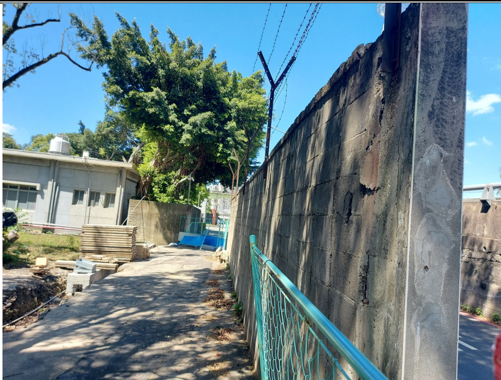
照片 2：圍牆位置，園區側。
