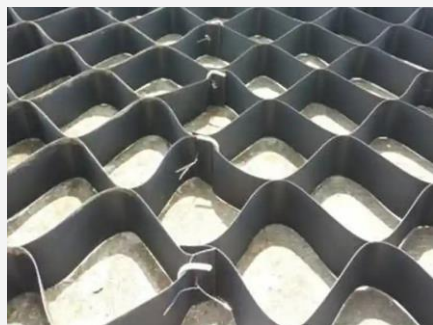
防沈陷格網施工參考示意
