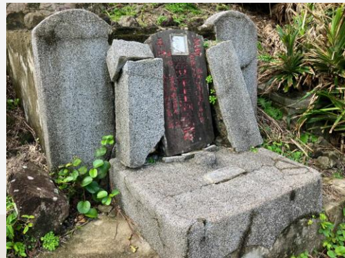
缺乏鋼筋鐵件抵抗拉應力，構造斷裂
