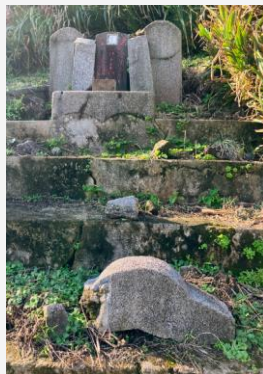
缺乏鋼筋鐵件抵抗拉應力，構造斷裂
