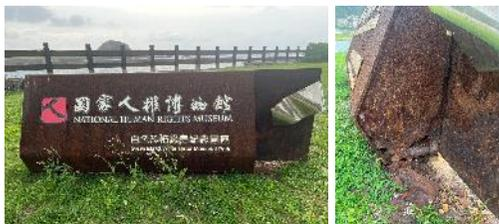
A1. 表面鐵片鏽蝕嚴重，結構已損壞。
