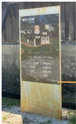
B3. 表面鐵片鏽蝕，結構受損。
